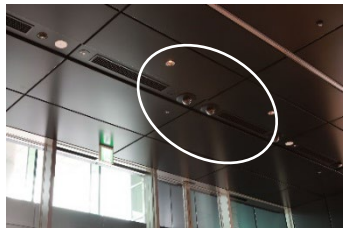
1階エントランス天井(西側)
