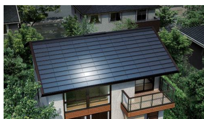
太陽光発電システム
