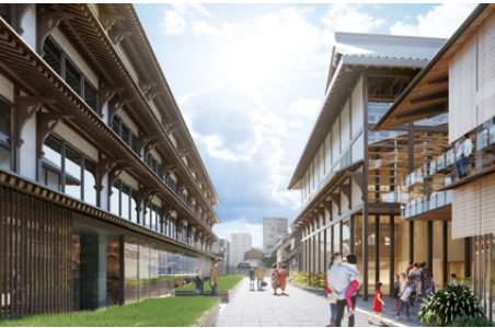
元新道小学校跡地活用計画 撮影：Kengo Kuma and Associates
