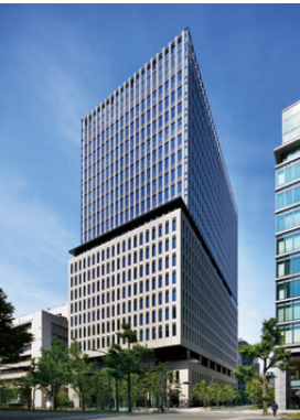
アーバンネット御堂筋ビル 外観
