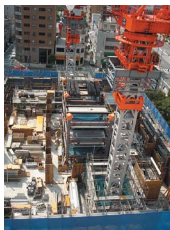
ビル建設現場
