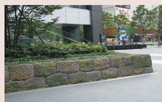
再現された石垣
