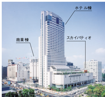
基町クレド全景
