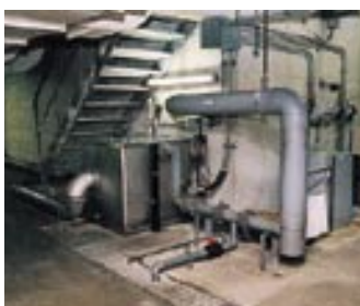
ビル内の雑水を処理する地下の中水設備
