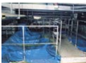
ビル内の雑水を処理する地下の中水設備
