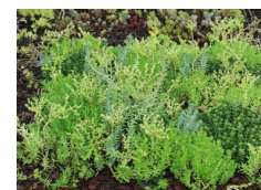
屋上を覆うセダム
