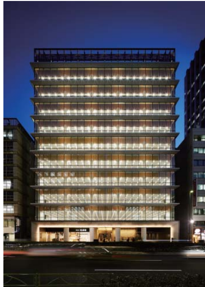
アーバンネット日本橋二丁目ビル (撮影：フォワードストローク)
