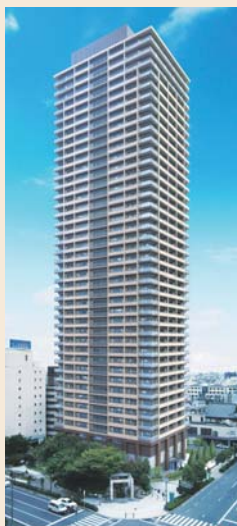
ウェリス上本町ローレルタワー 外観
