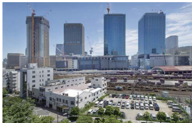
工事中のグランフロント大阪(2012年7月31日現在)
