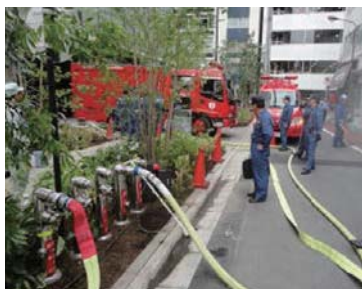
消防活動を支える設備を設置
